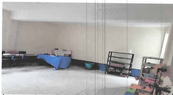
Foto 6 ; Pintura en en interior del aula
