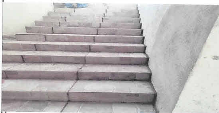
Instalacion de piso en gradas
