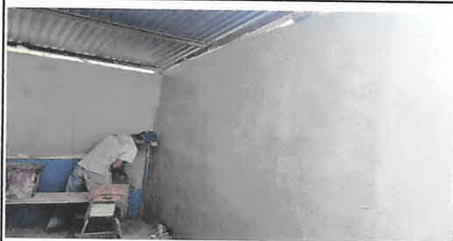
Foto: 3 Repello en paredes
