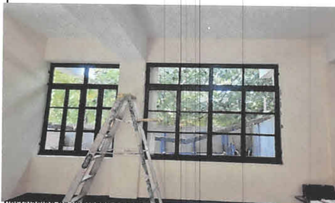
Instalacion de ventanas primer nivel
