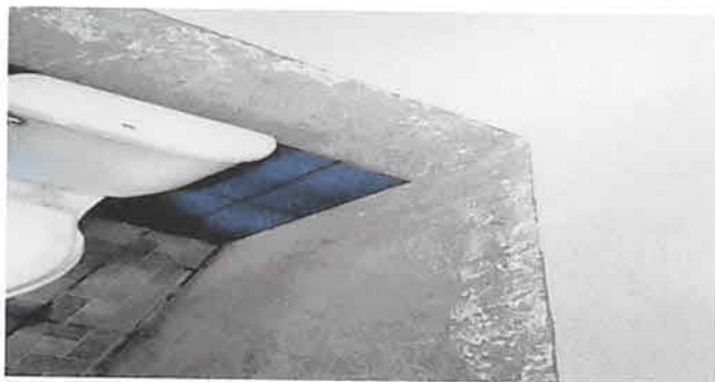
Foto1: INSTALACION DE AZULEJOS EN PAREDES DEL BAÑO
